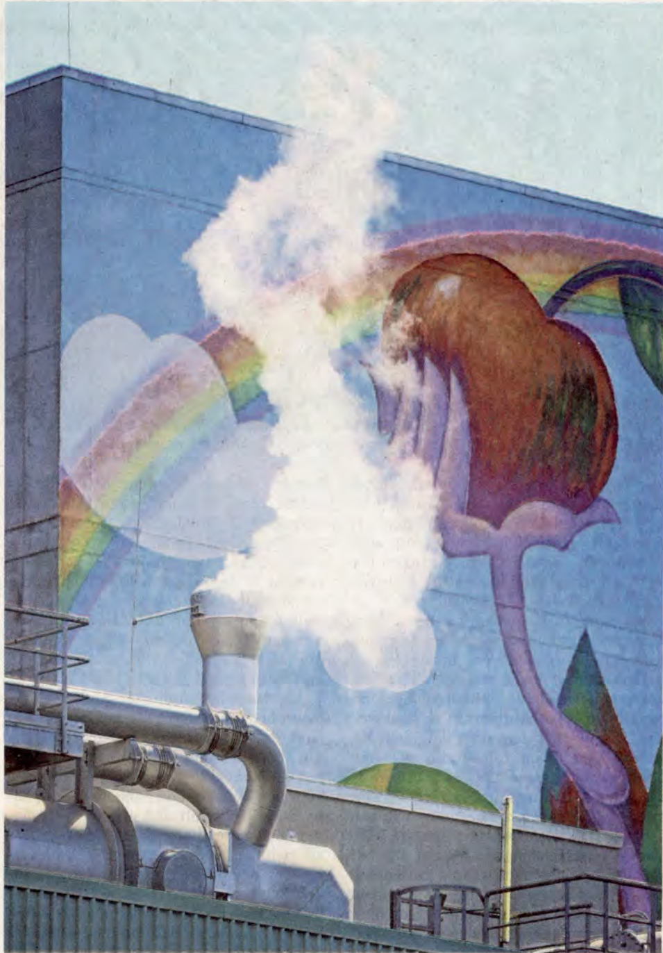
Die Fernwärme entsteht in der Böblinger Müllverbrennungsanlage. Foto: factum/Simon Granville
