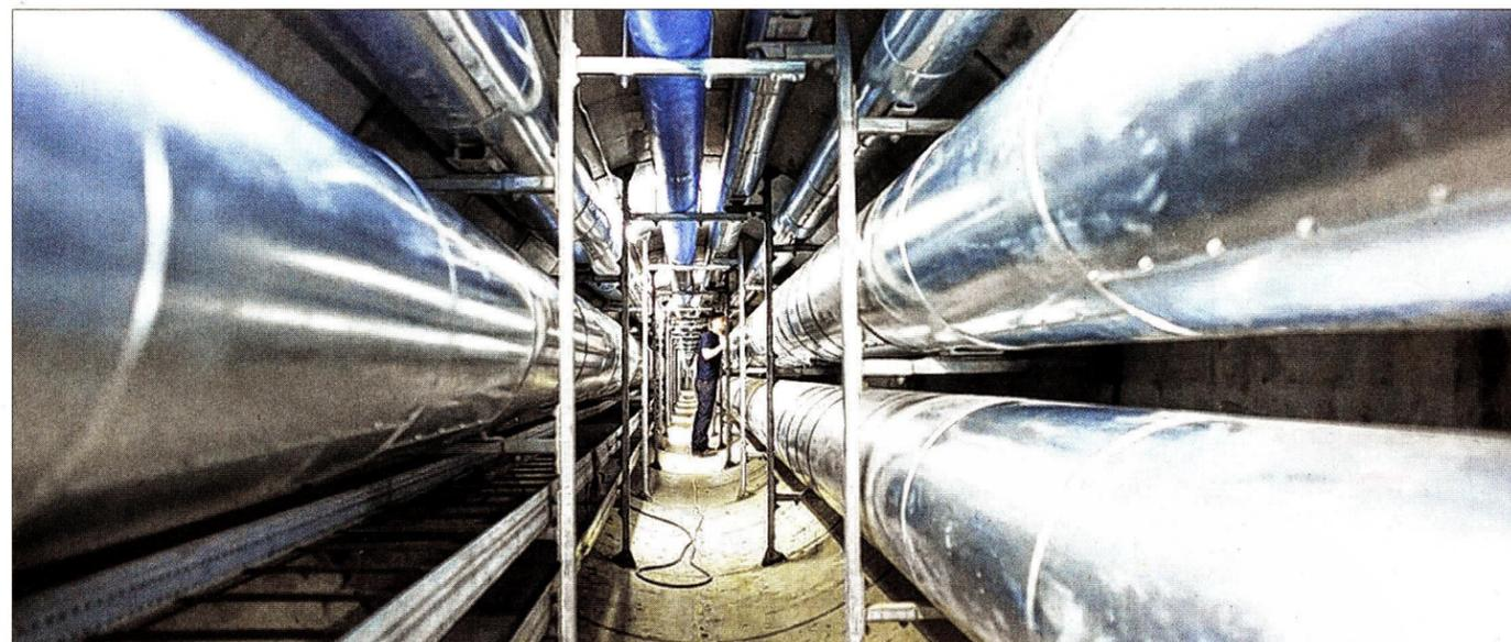
Diese Rohre bringen die Wärme vom Mercedes-Benz-Werk unter der Tübinger Allee in die Sindelfinger Innenstadt.
